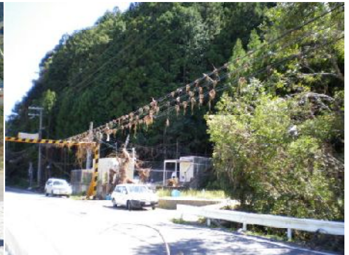
熊野川沿いの国道の電線にも流木や草が引っ掛かっている
