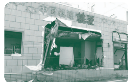
津波の被害を受けた富岡駅前の状態
