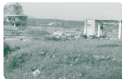
津波の被害を受けた浪江町の請戸地区の状態
