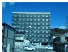
現在の田老地区（上） 災害公営住宅（下）
