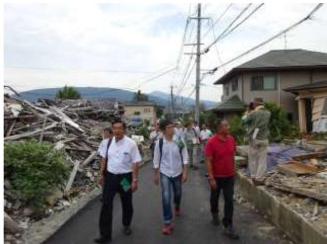
多くの家屋が倒壊した益城町では5ヵ月たった今も、壊れた建物が手つかずのままで残されています。地盤が1メートルも沈下したという被害の大きさが生々しく残っています。30余の解体業者が入っていますが、分別作業等の関係で、1家屋の解体に2週間、月60軒しか解体がすすまず、3,000戸の解体が終了するのは50ヶ月、4年後になるということです。
