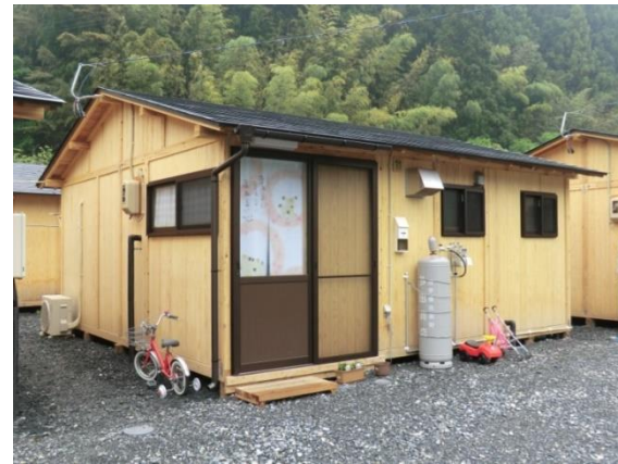
住田町の木造仮設住宅
