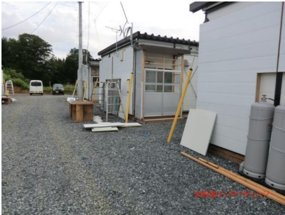
高価で劣悪な居住環境。カビの発生など。
