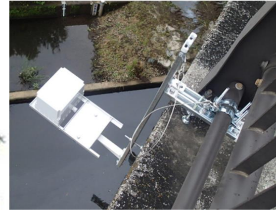
橋梁に設置するタイプ
