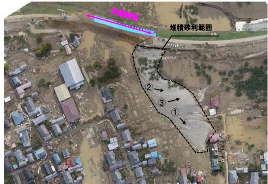
図12 桜つづみ堤防(側帯)のり面崩落地点,堆積物調査 ①堆積砂利最大3.0m,②堆積1.5m,③堆積2.0m 2019.10.18撮影(2020.2.2国土交通省住民説明会資料)
