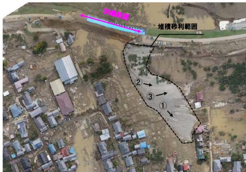
図12 桜つづみ堤防(側帯)のり面崩落地点,堆積物調査 ①堆積砂利最大3.0m,②堆積1.5m,③堆積2.0m 2019.10.18撮影(2020.2.2国土交通省住民説明会資料)
