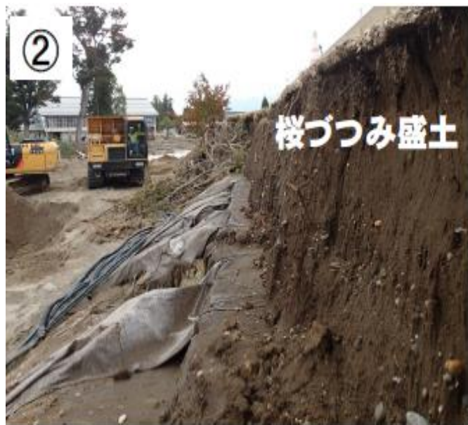
図10 桜つづみ盛土 (側帯)崩落地点, ②決壊地点上流側 2019.10.21撮影( 国土交通省資料)
